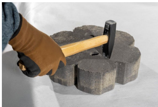
3. Een tot twee gerichte slagen op de onderkant van de verbindingstukken
