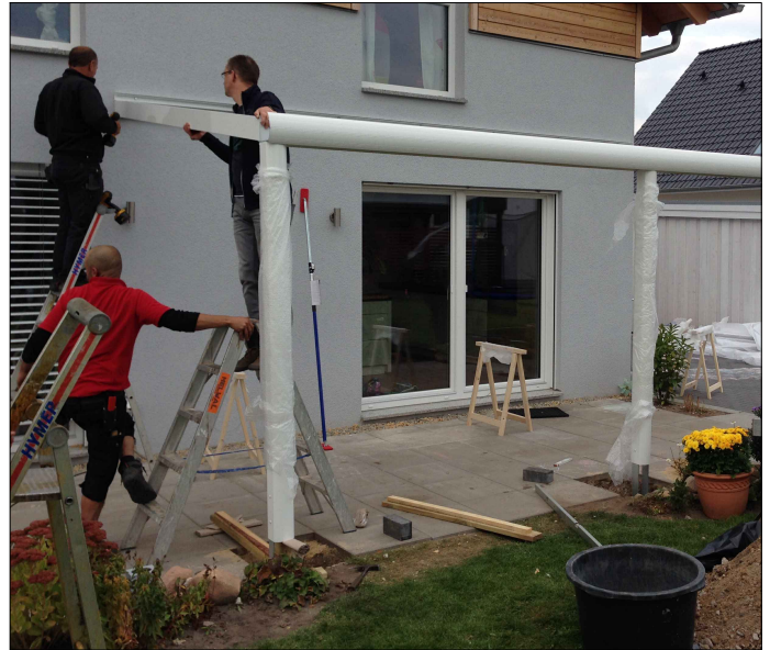
Plaats de twee buitenste spanten en lijn deze uit langs de muur en de regengootgording.
