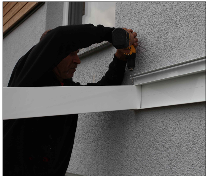
Boor de schroefgaten voor met een 4 mm metaalboor en schroef de spanten op de twee gordingen vast met elk één parkerschroef (C101-025).
