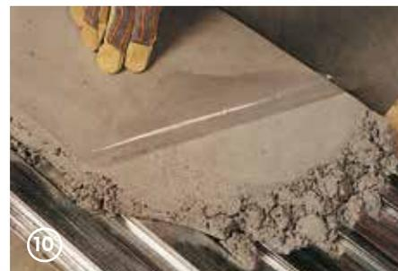
Forciertes Trocknen der Vergussmasse muss vermieden werden (Schwundrissbildung). Beachten der DIN 18560-2 und ggf. einen Fugenplan erstellen.
